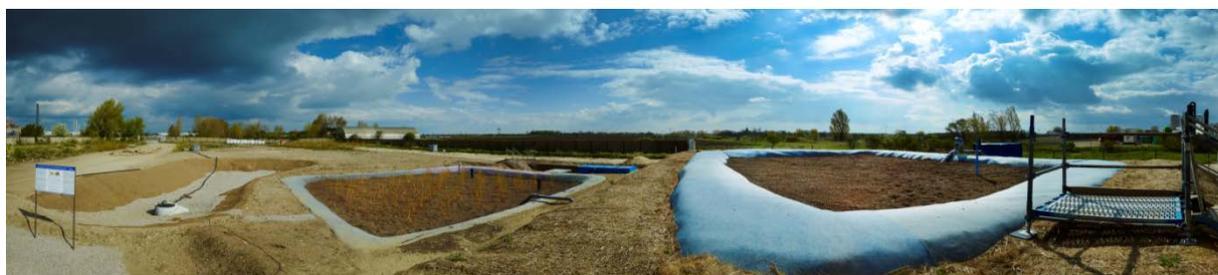
Abbildung 32: Die Pilotanlage in Leuna, die künftig im technischen Maßstab täglich bis zu 600.000 Liter kontaminiertes Grundwasser reinigen soll.
